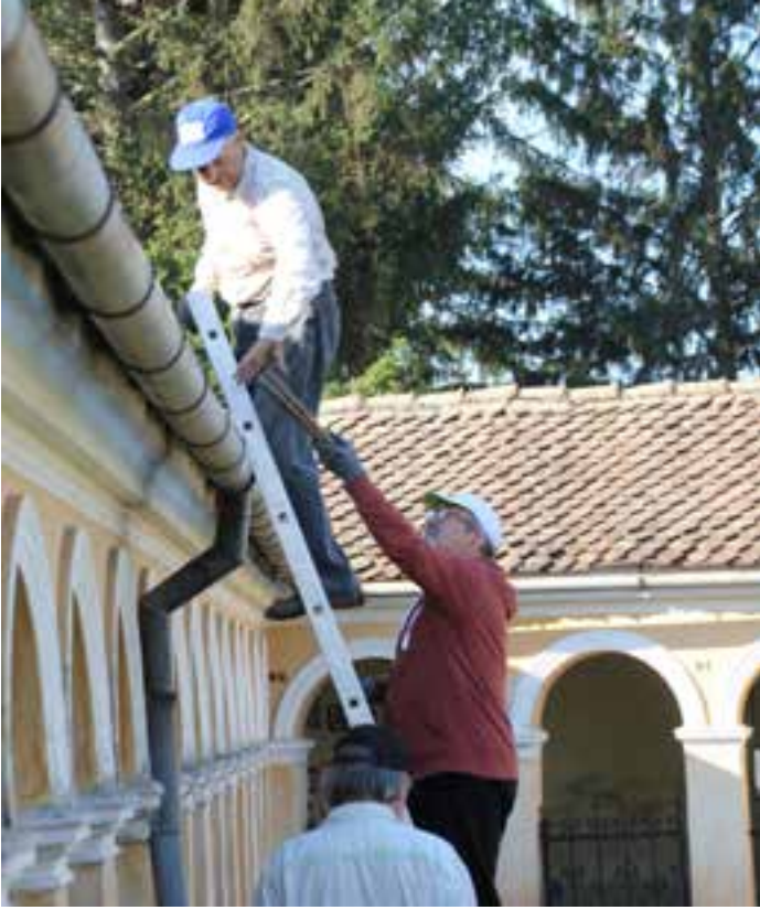
Dachreparaturen an den Gruften
