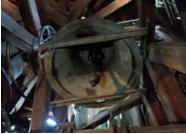
Sicherung der Glocke
