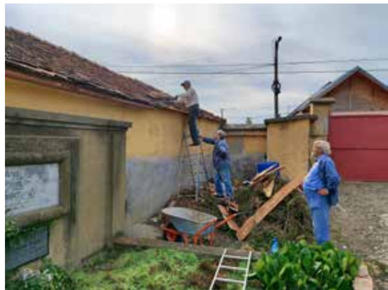
Dachreparaturen auf dem Neuen Friedhof
